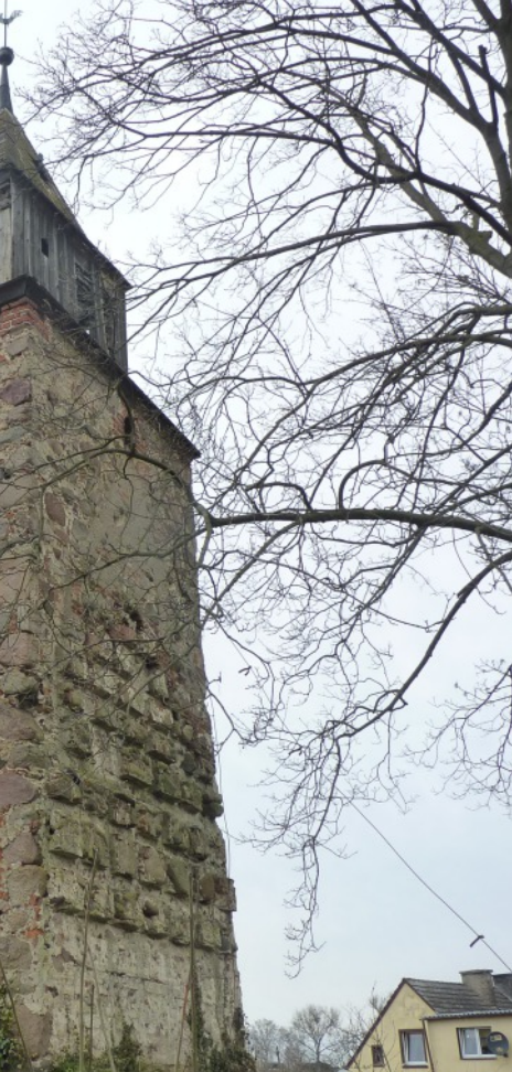
Kamienna wieża kościelna w Tarnówku
